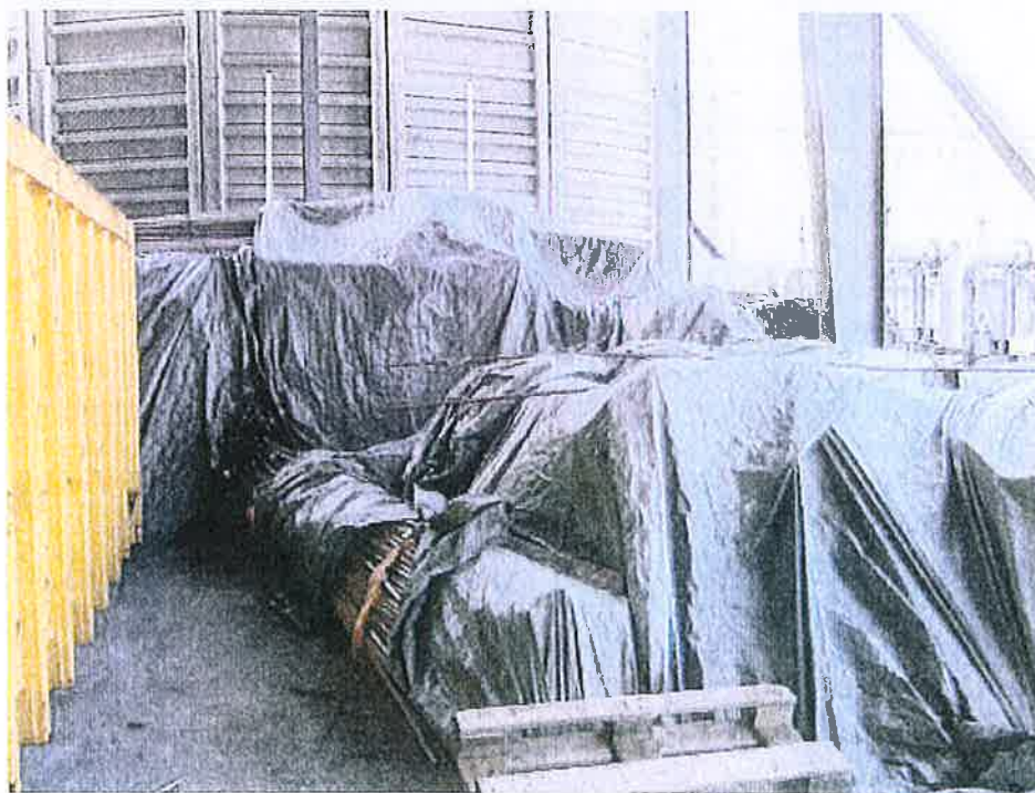
Bilde 5: Nåværende lagerplass for titanrør (på tett dekke under tak).
