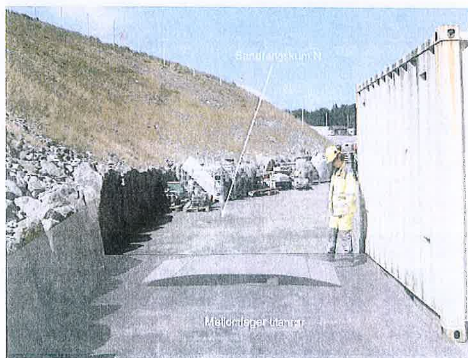
Bilde 3: Sandfangkum N ved område som var brukt til midlertidig lagerplass for titanrør
